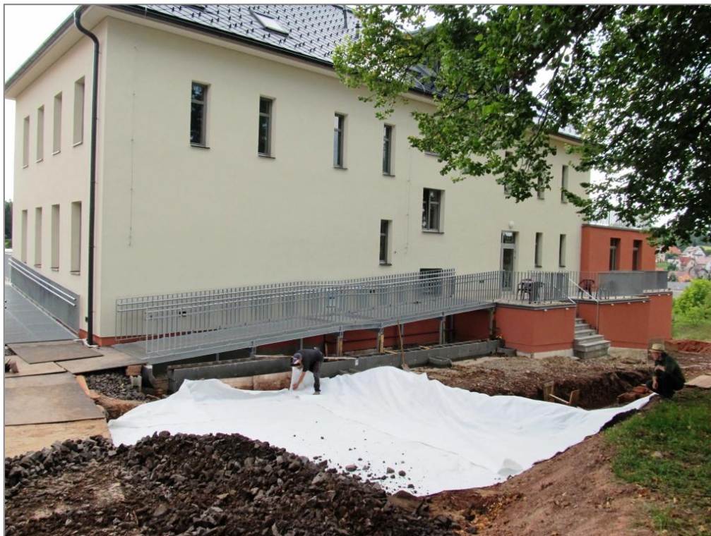
Pokládka geotextílie na severní straně objektu CBB – podzim 2012
