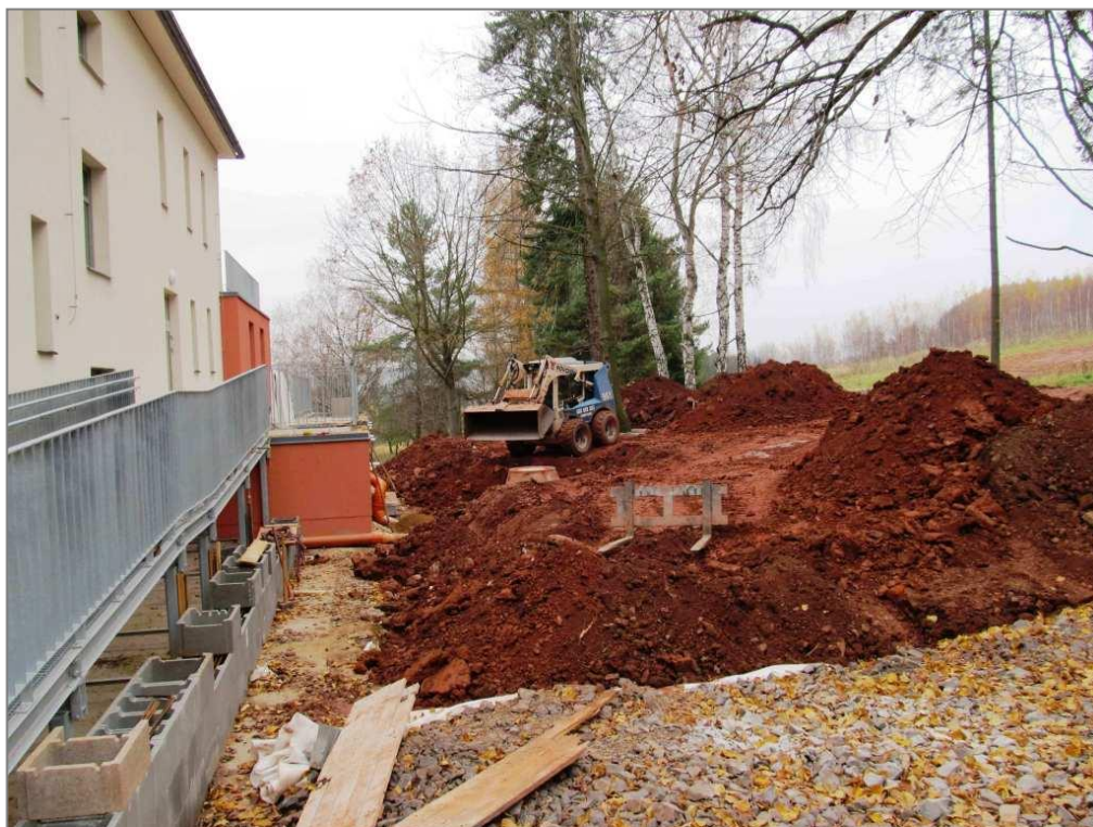
Pozemní práce na severní straně objektu CBB – podzim 2012
