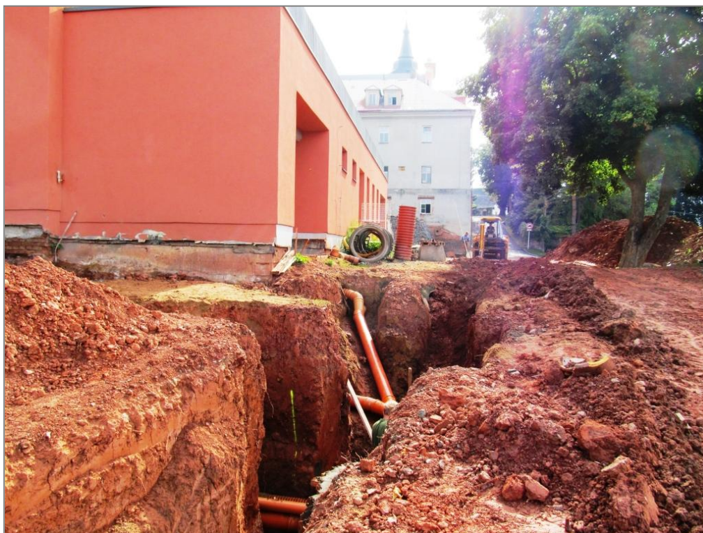
Pokládka kanalizace na jižní straně objektu CBB – září 2012
